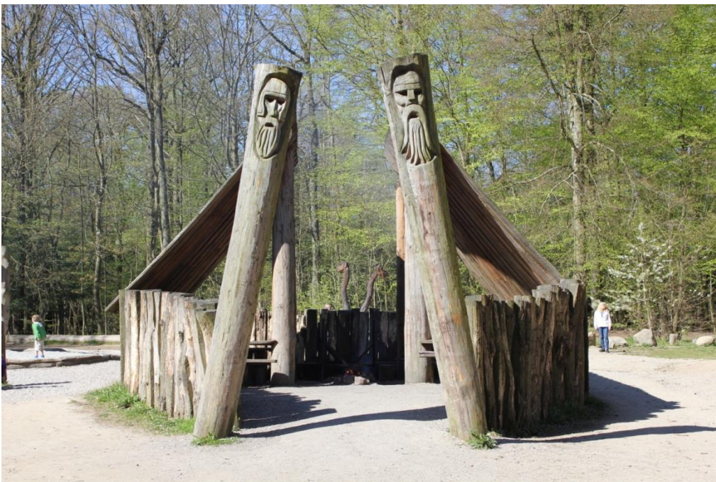
Figur 20. Samlingsfacilitet, hvor konstruktionen understøtter et stort lysindfald. Åbningen skal ideelt set pege mod syd for at understøtte lysindfald og vind fra vest, nord og øst, som er fremherskende i den kolde årstid. Placeringen midt på en naturlegeplads er uheldig.
