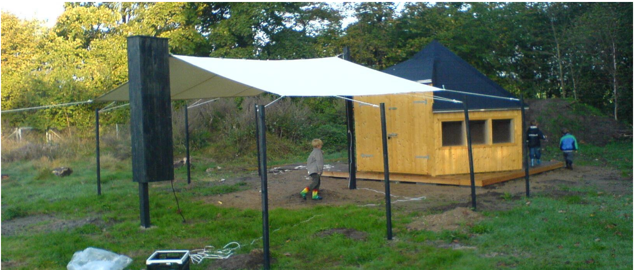
Figur 14. Eksempel på en facilitet rettet mod små børnegrupper. Det sekskantede hus kan rumme 10-15 børn, der kan sidde på bænke rundt i randen af huset. Huset kan åbnes med dobbeltdøre mod syd. De to sejl kan sættes op med elastiksnore på de opsatte pæle. Pælene kan fjernes, idet de står løst i nedstøbte huller. Sejlene kan trækkes ind i den sorte kasse, der også kan aflåses efter behov.
